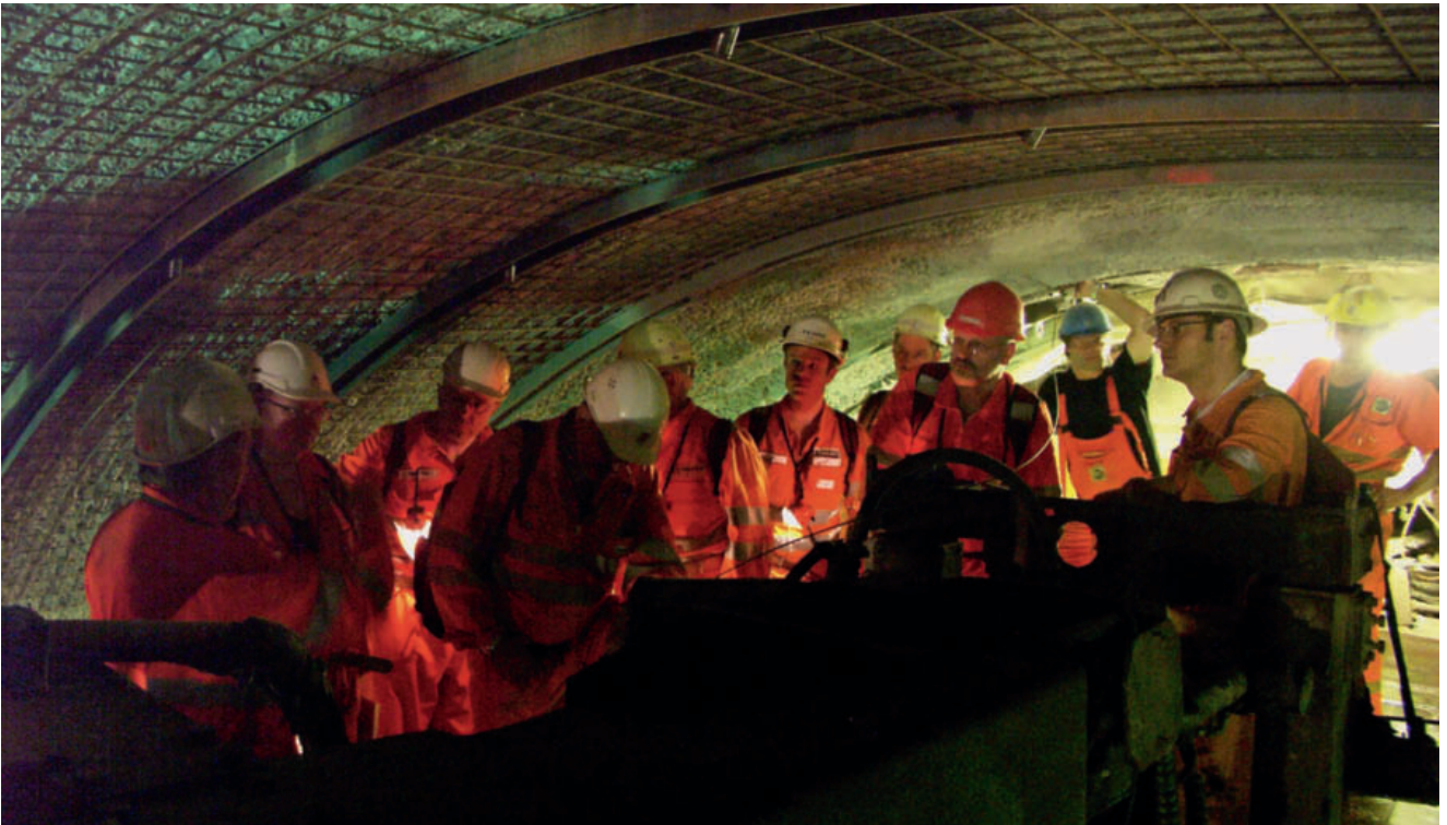
► Bild 7 Analysen vor Ort zwischen Unternehmer, Projektgenieur, örtlicher Bauleitung, Geologe, SIOP-Experten und Bauherrenvertretern im Teilabschnitt Faido
