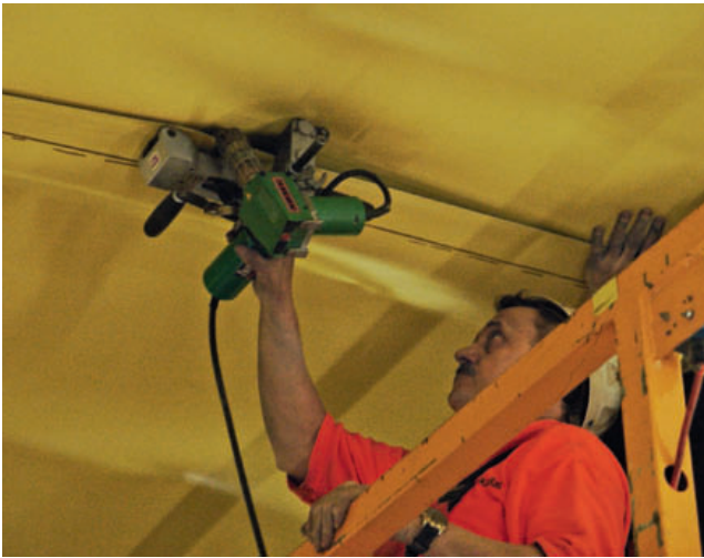
► Bild 8 Einbau eines Abdichtungssystems, das zusammen mit der Industrie für die NEAT-Basistunnel am Lötschberg und am Gotthard entwickelt wurde.
