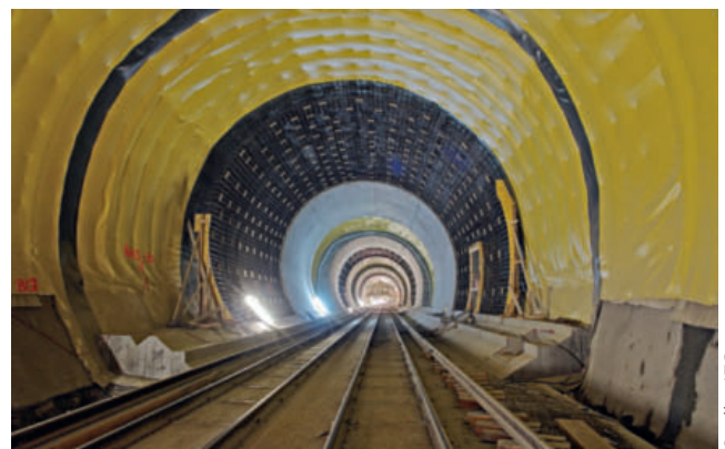
► Bild 3 Umsetzung der geforderten Nutzungsdauer von 100 Jahren in ein bauliches Konzept – zweischaliger Ausbau mit Abdichtungssystem
