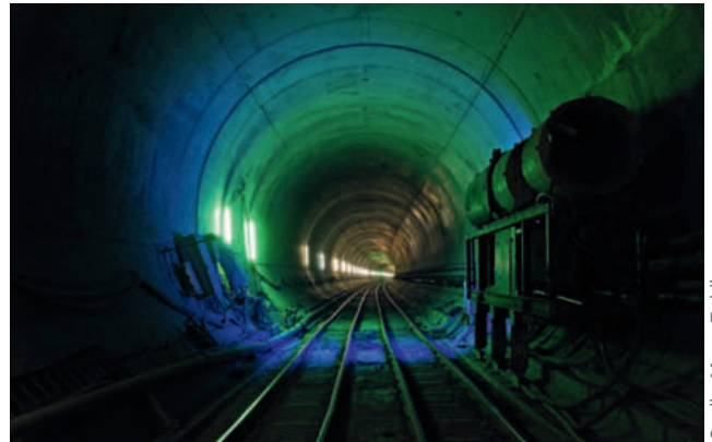
► Bilder 6a und b Fluchtcontainer auf dem Installationsplatz in Sedrun und grüne Fluchtwegmarkierung im Tunnel
