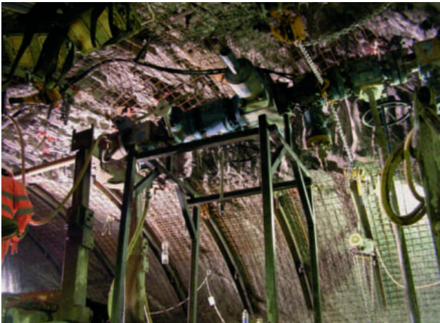
► Bild 2 Prevertergeschützte Voraussondierung ab der TBM Ost in Faido
