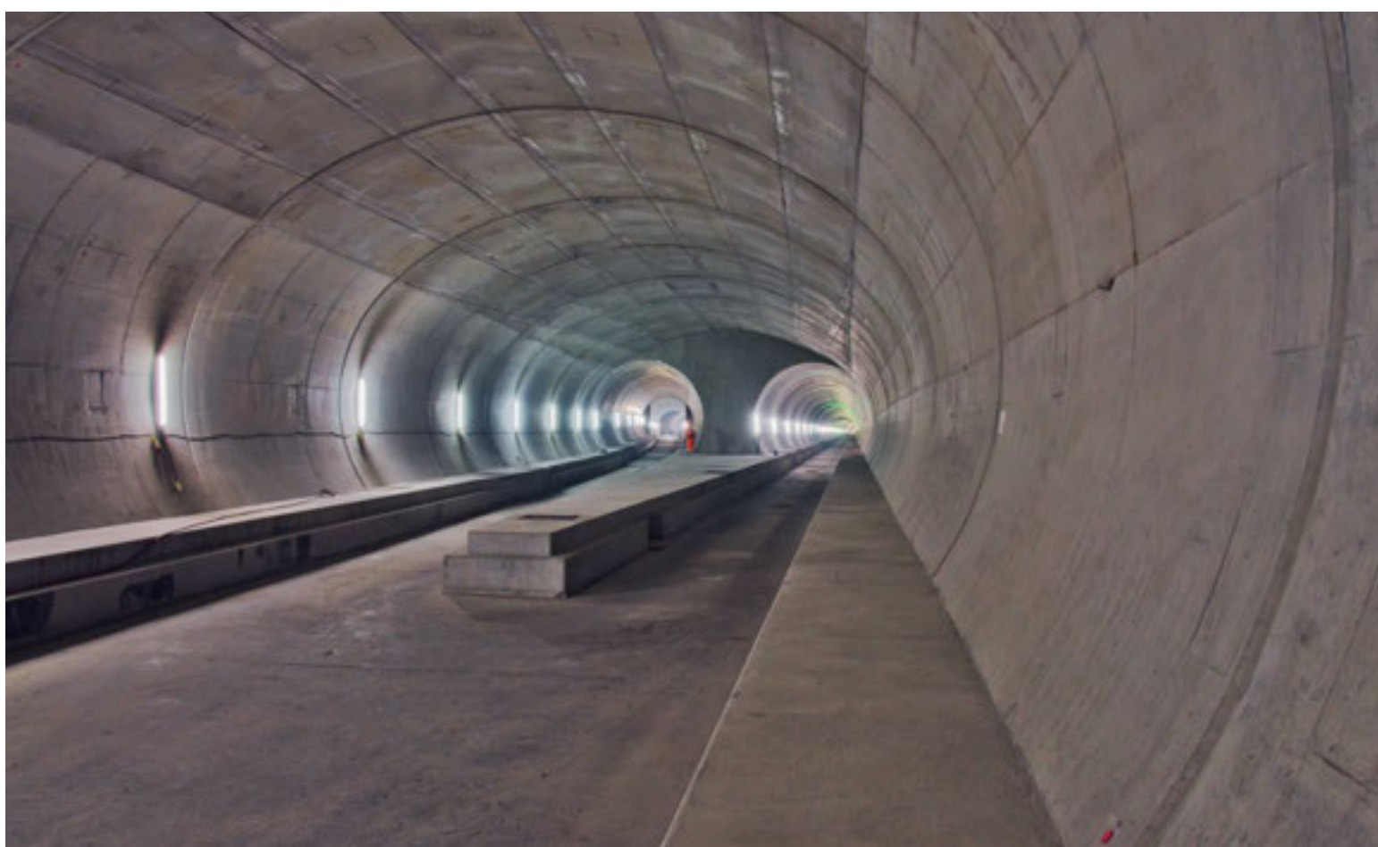
Unterirdische Tunnelverzweigung am Gotthard Basistunnel, im Robbau fertiggestellt
