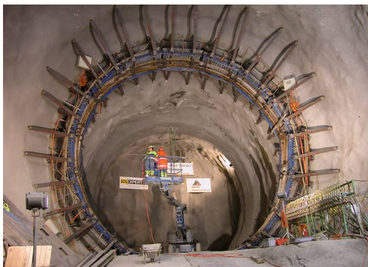
Abbildung 4. Grossversuchsstand Stahleinbau nach Versuchsende
