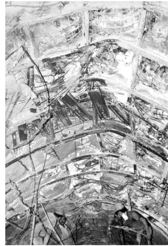
Abb. 1 (links): Die Sanierung einer verdrückten Stollenstrecke mit Anpassung der Profilform (Sicherheitsstollen Gotthard Strassentunnel, Schweiz)
