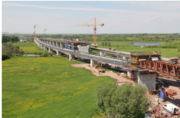
Bild 4: Umweltschonende Vorkopfbauweise bei der Saale-Elster-Talbrücke (Bild DB)
