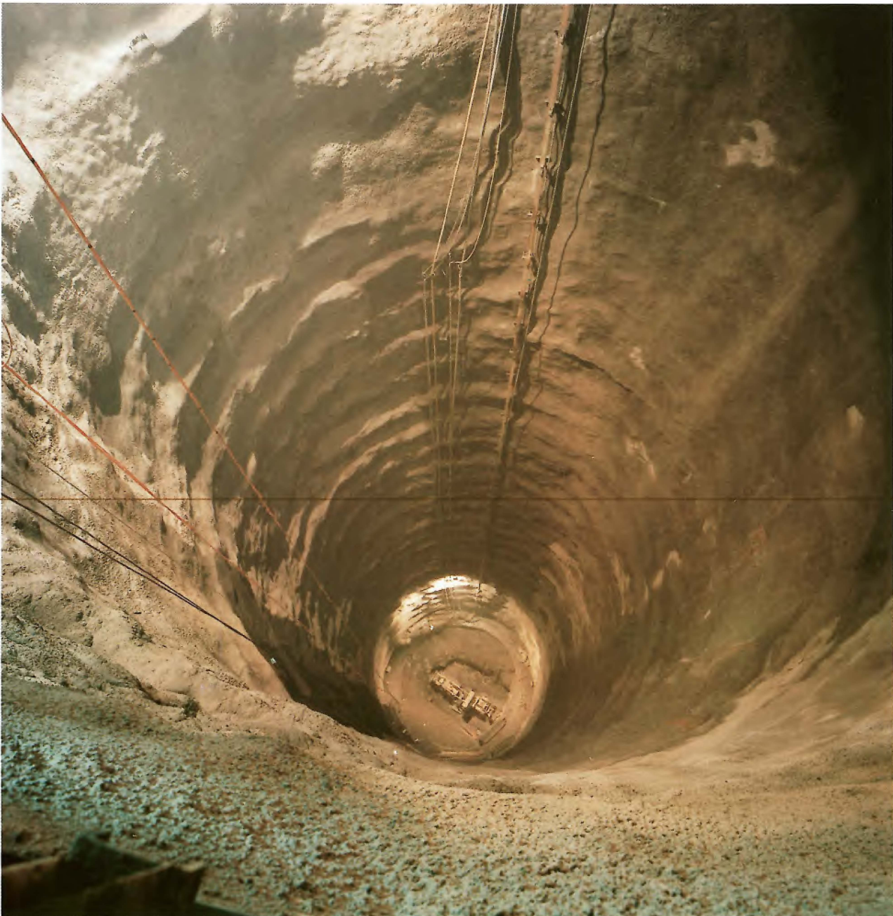
Bild 5.2. Der Ausbruch des Druckschachtes und des Vertikalschachtes erfolgte unter Anwendung des Raiseboring-Verfahrens. Die auf 2,10 m aufgeweitete Pilotbohrung diente zum Abtransport des bei der weiteren Ausweitung anfallenden Materials (Foto Wolf, Schruns).
