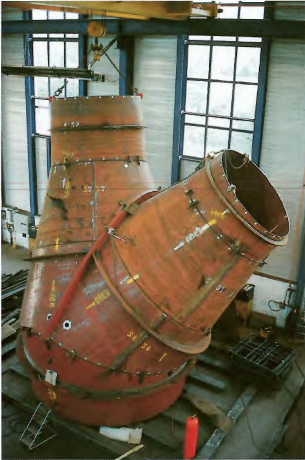
Bild 5.4. Die Endzone des Druckstollens, der Druckschacht sowie die beiden Verteilleitungen sind mit Stahl gepanzert. Die teilweise vormontierten Teile des Hosenrohres wurden vor Ort zusammengeschweisst. Die beiden Verteilleitungen und das Hosenrohr werden einer Druckprobe unterzogen.
