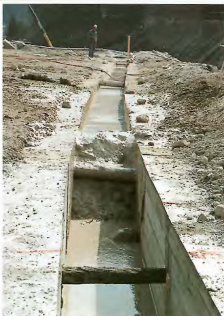
Einphasendichtungswand in Ausführung.
