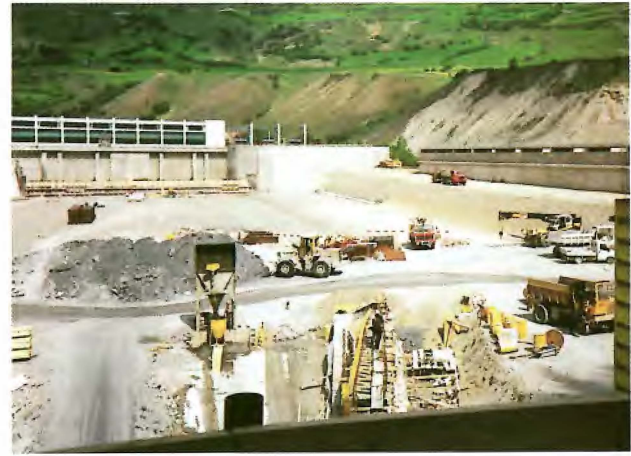
Bild 3.10. Das Ausgleichsbecken mit einem Nutzvolumen von 260\,000 \text{ m}^3 liegt in der ursprünglichen Ebene östlich der im Hintergrund abgebildeten Zentrale.
