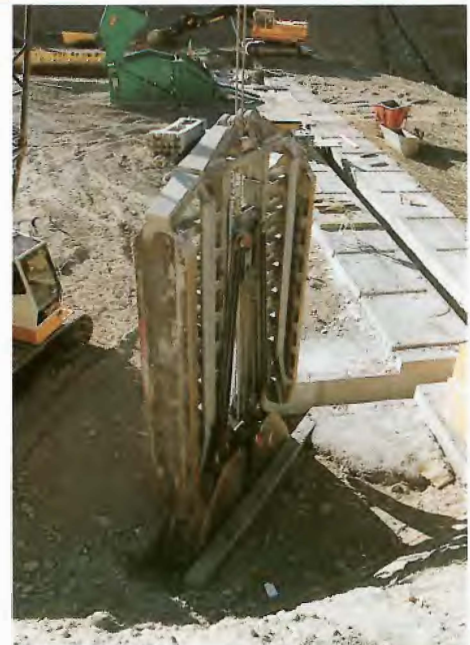
Einphasendichtungswand in Ausführung.
