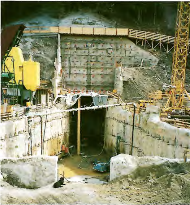
Bild 3.13. Vom tiefsten Punkt des Einlaufbauwerkes wird im fallenden Vortrieb der Druckstollen ausgebrochen und betoniert.
