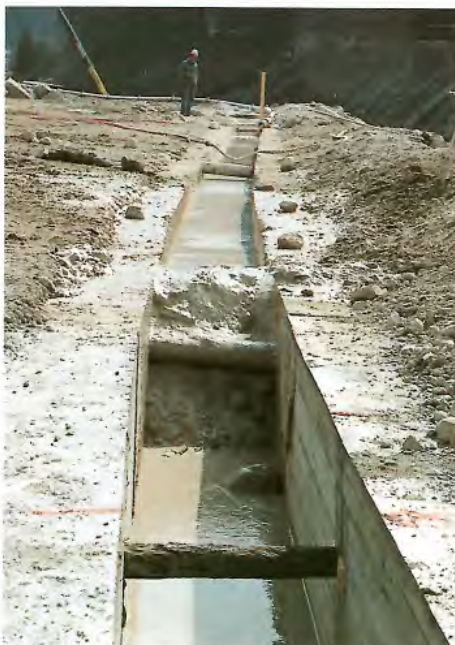
Einphasendichtungswand in Ausführung.
