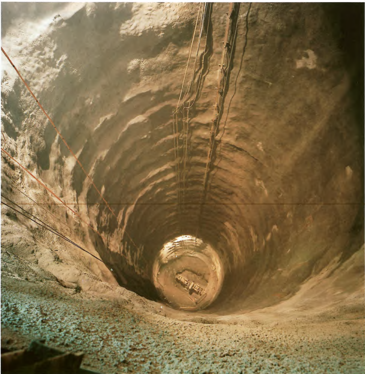
Bild 5.2. Der Ausbruch des Druckschachtes und des Vertikalschachtes erfolgte unter Anwendung des Raiseboring-Verfahrens. Die auf 2,10 m aufgeweitete Pilotbohrung diente zum Abtransport des bei der weiteren Ausweitung anfallenden Materials (Foto Wolf, Schruns).
