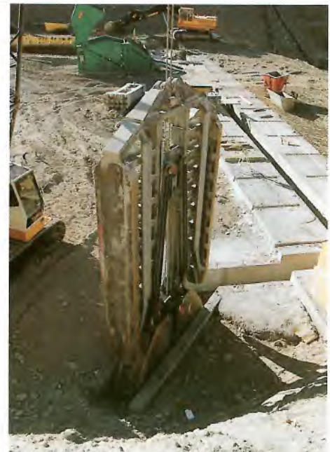
Einphasendichtungswand in Ausführung.
