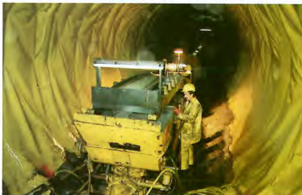
Bild 9. Nach dem Ausbruch wird das Stollenprofil mit Kunststoffbahnen abgedichtet, bevor der Beton eingebracht wird. Baulos San Niclà.
