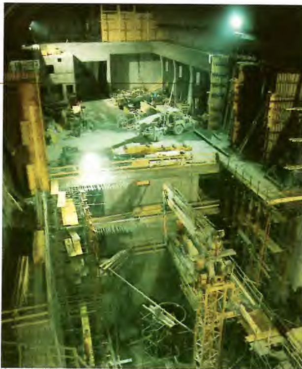
Bild 6.9. Der Innenausbau der Kaverne Martina ist eine anspruchsvolle Aufgabe, die bei engen Platzverhältnissen bewältigt werden musste.
