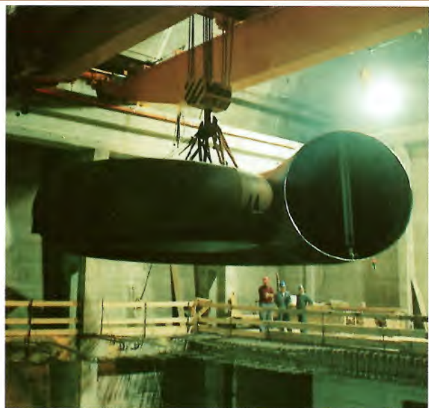
Bild 5.5. In der Kavernenzentrale Martina wird das Spiralgehäuse mit einem 100-t-Brückenkran eingebaut.
