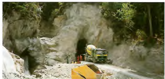
Bild 4.8. Übersicht über das Fassungsgebiet mit ausgebrochener Entsanderkaverne und Bachumleitung. Die Fassung befindet sich am Fusse einer natürlichen Gefällsstufe. Links im Bild ist die provisorische Umleitung des Baches zu sehen. Die Entsanderkaverne ist bereits ausgebrochen.
