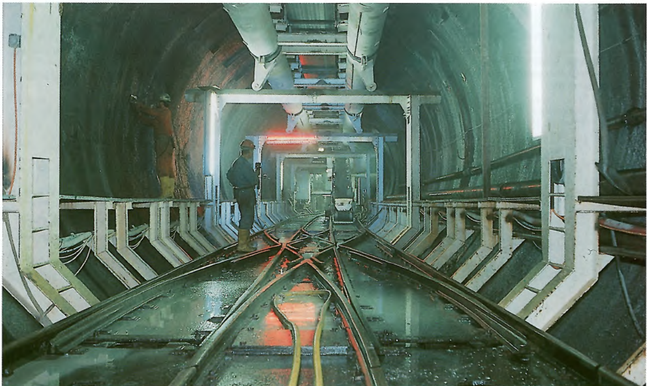
Bild 8. Ausweichstelle für die Stollenbahn als hinterster Teil der Tunnelbohrmaschine.
