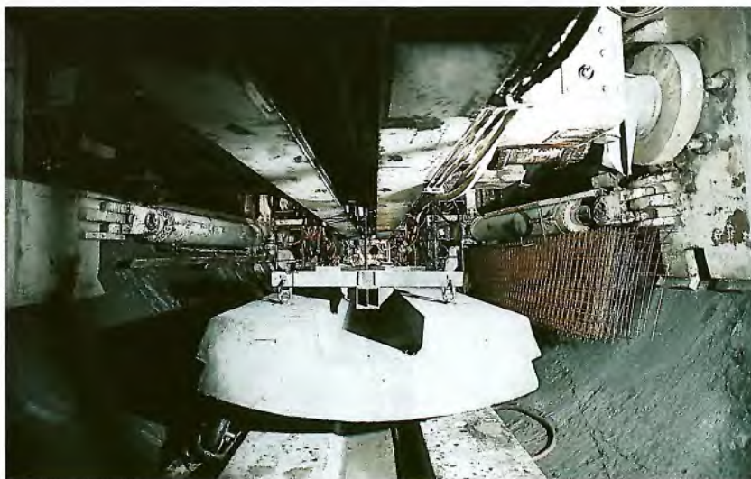
Bild 4.3. Sohlübdinge als temporäre Schienenschwellen werden im Baulos 3 in die Stollenverkleidung integriert.
