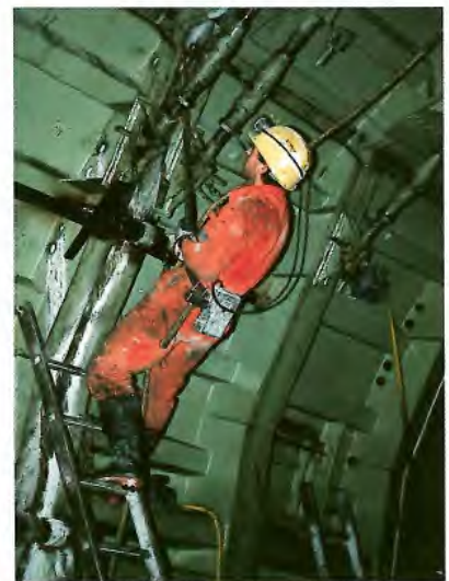
Bild 4.4. Mineur bei der Kontrolle der Full-round-Schalung im Stollen.
