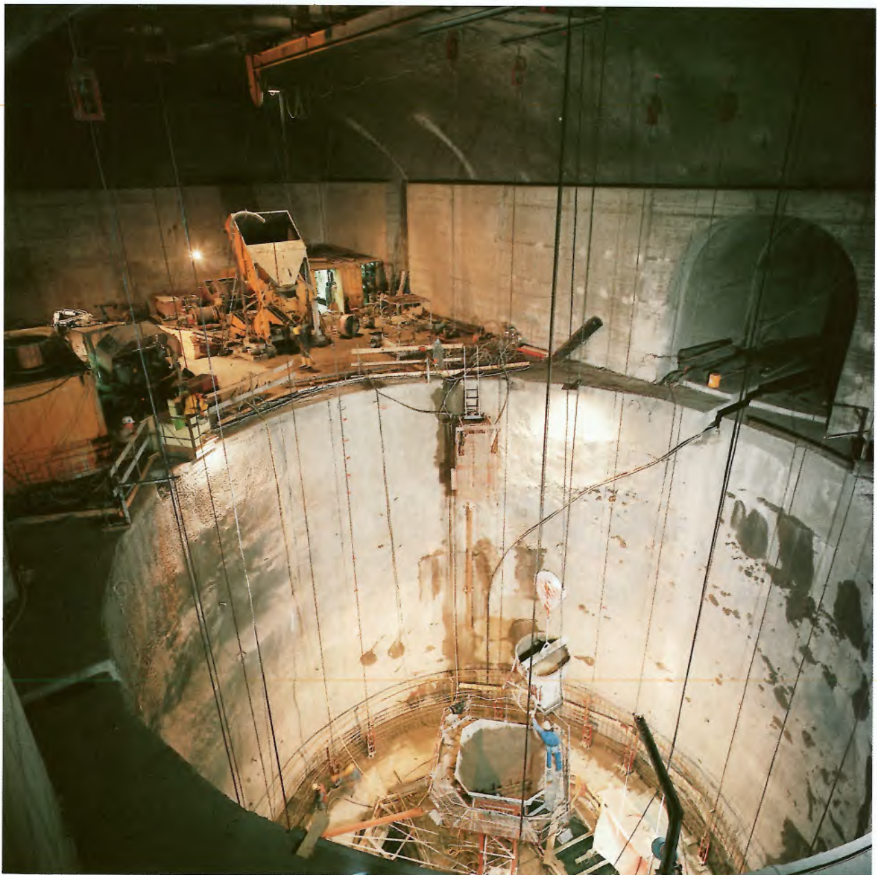
Bild 5.3. Die Betonauskleidung des Vertikalschachtes erfolgte mittels Gleitschalung vom Schachtfuss nach oben. Zur Abdichtung des Schachtes ist eine Dichtungsfolie auf den mit Gunit geschützten Fels aufgebracht worden (Foto Wolf, Schruhs).
