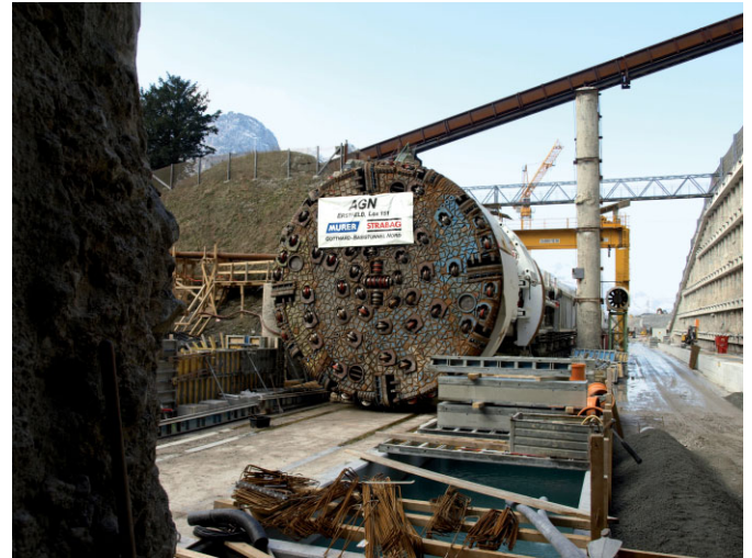
Fig. 4. TBM at West Erstfeld before starting work Bild 4. TBM West Erstfeld vor Vortriebsbeginn
